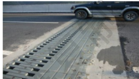
梳齿板式伸缩装置 代号S
